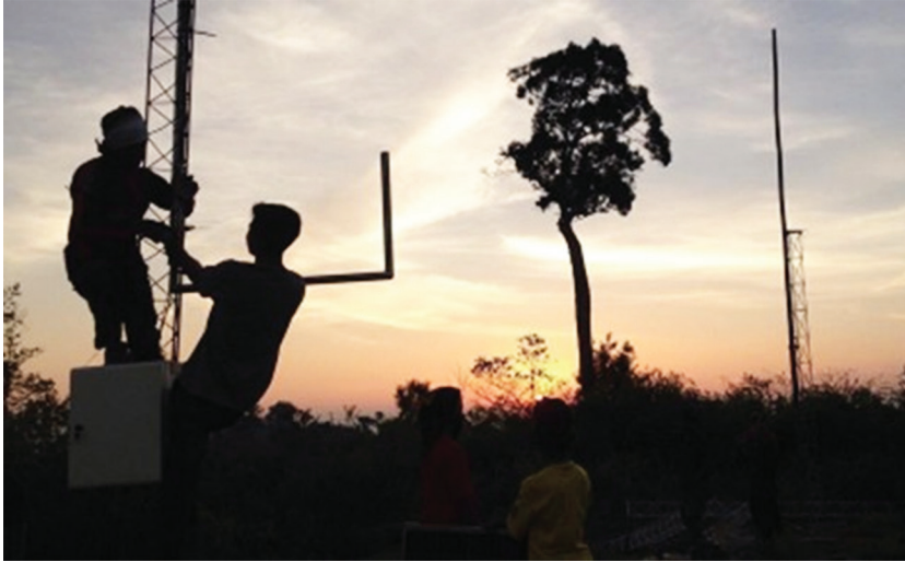
Gambar 1 Pemasangan Infrastruktur Internet Komunitas di Kasepuhan Ciptagelar (Sumber Foto: Common Room)
